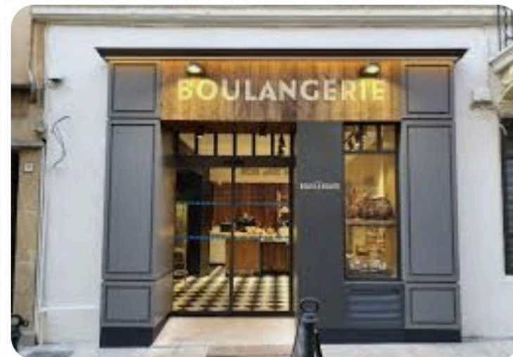
KONCEPTOR Travaux d'agencement boulangerie ...
